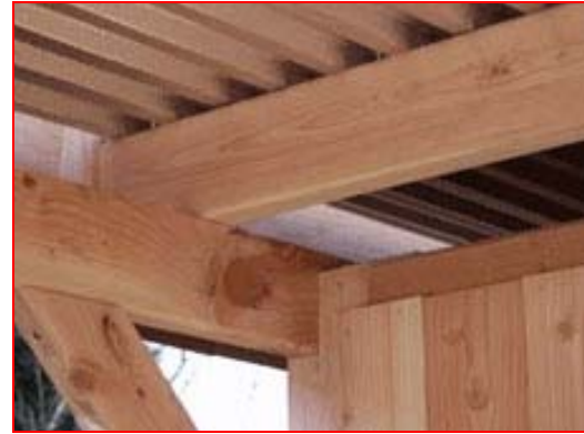
Tragbalken, Sparren, Diagonalstrebe und Dachtafel
