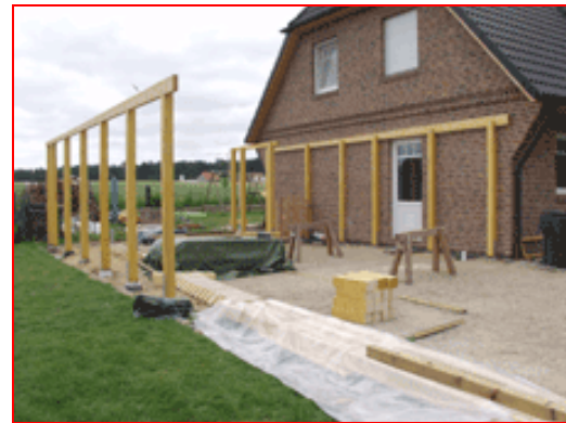
Pfosten und Tragbalken
