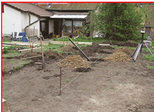
Bestimmen und genaues markieren der Fundament- bzw. Pfostenlöcher
