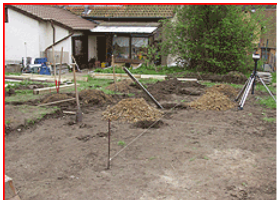
Bestimmen und genaues markieren der Fundament- bzw. Pfostenlöcher
