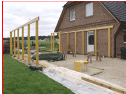
Pfosten und Tragbalken
