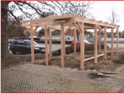
Carportgerüst: Pfosten, Tragbalken und Sparren
