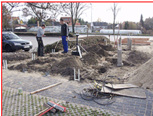
Einbau von Einzel-Punktfundamente
