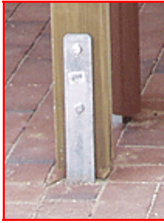
Einbetonierter H-Form-Pfostenträger
