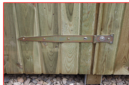
Einbau Türband BP
