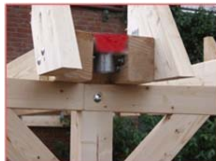
Fallrohrstutzen an der Regenrinne
