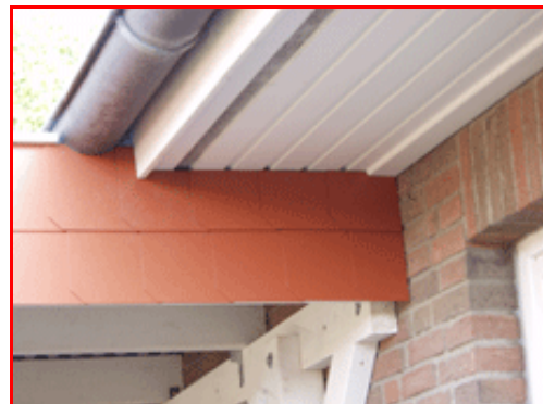
Blendenanpassung am Dachunterschlag des Wohnhauses
